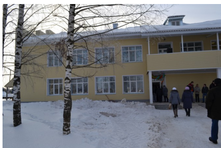
Здание Дома культуры после реконструкции
